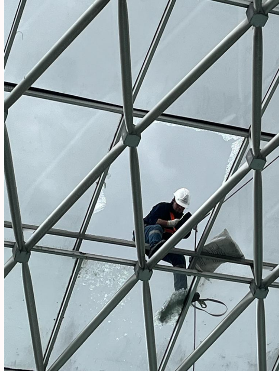
Mantenimiento de fachadas.
