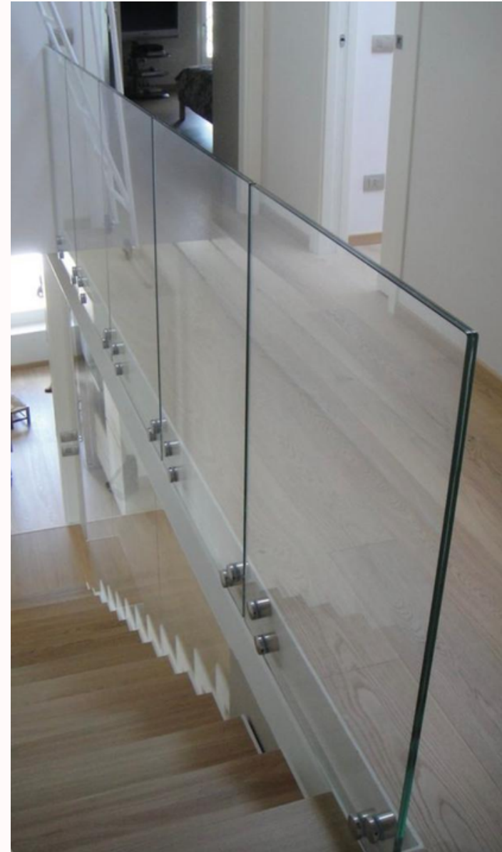
Barandas en vidrio y acero inoxidable
